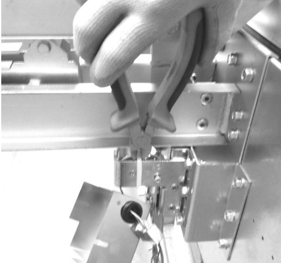
Rys. 35. Przecinanie opaski zaciskowej w celu odbezpieczenia zamka
