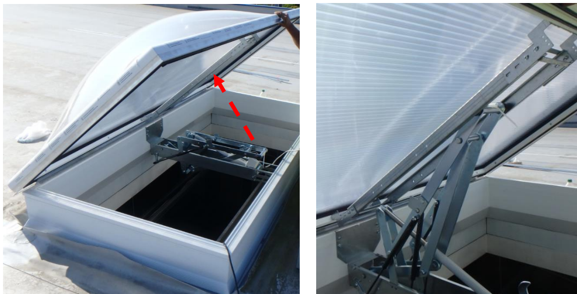
Rys. 29. Ręczne uniesienie skrzydła kłapy i otwarcie mechanizmu do wysokości trawersu.
