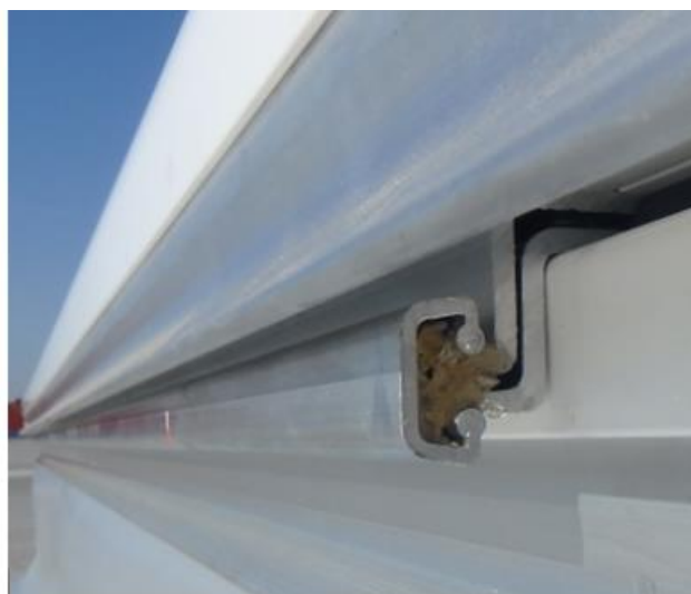
Rys. 21. Zawias z zamontowanym łącznikiem.
